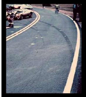
El desnivel previene que un conductor pueda regresar a la vía de rodaje y en ocasiones causa que un conductor reajuste demasiado el ángulo del volante para montar sobre el desnivel, causando que se pierda el control de vehículo y una colisión. Lugares con promesa para el borde de seguridad incluye curvas horizontales, cercano a buzones, accesos sin pavimentar y en recubrimientos.
